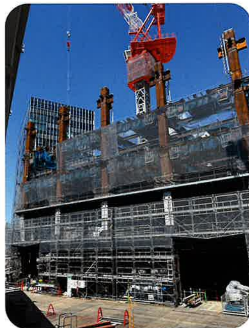
(仮称) OMIYA SOUTHGATE増築プロジェクト
