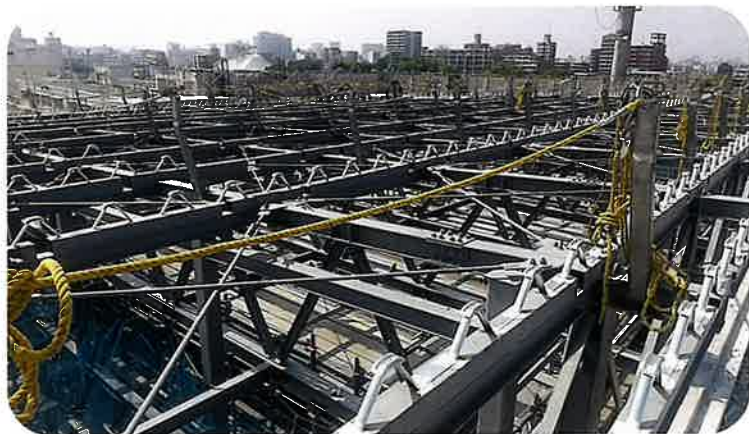
都立城南職業能力開発センター大田校(5)改築工事
