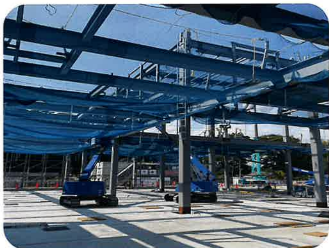
野田学校給食センター新築工事
