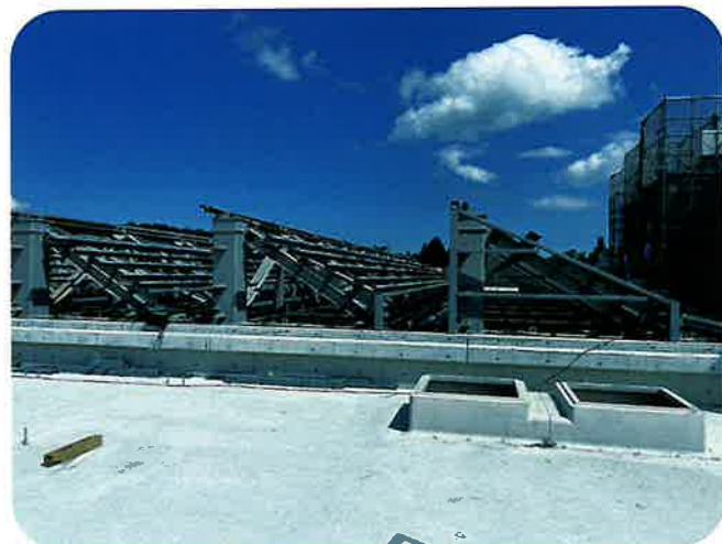
セコムHDセンター御殿場建替工事
