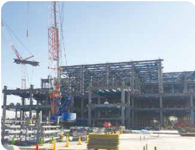
森永乳業株式会社利根工場新棟建設工事
