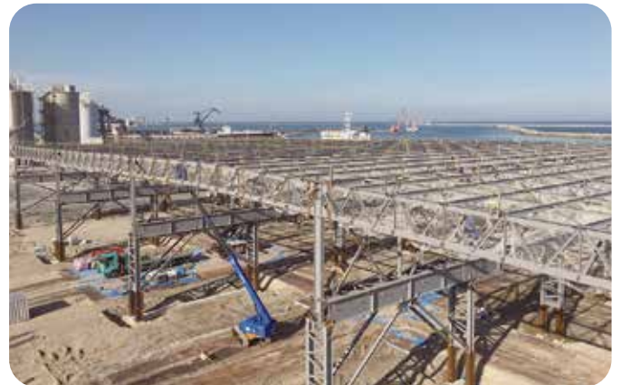
(株)アイ・テック相馬工場新築工事
