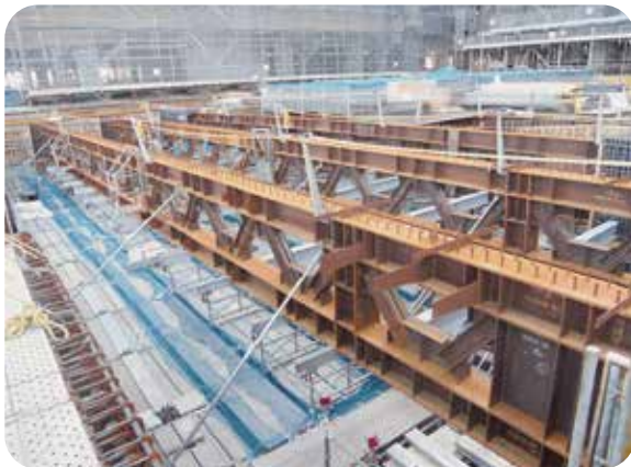
(仮称)帝京大学八王子キャンパス新校舎棟新築工事
