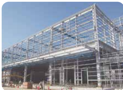
日本一野田新物流センター新築工事
