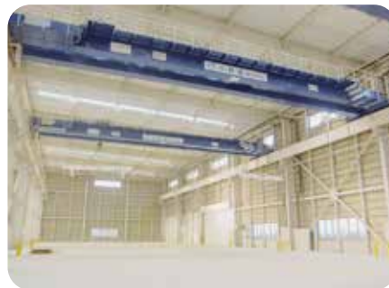
小野建(株)浦安センター増築工事
