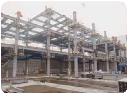
株式会社ホンダテクノフォート30期本社増築建築工事
