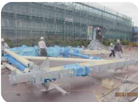
千葉県立富津公園屋内温水プール大規模改修建築工事
