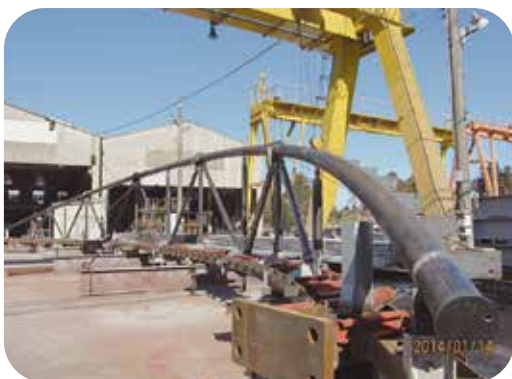
中郷中学校屋内運動場改築工事
