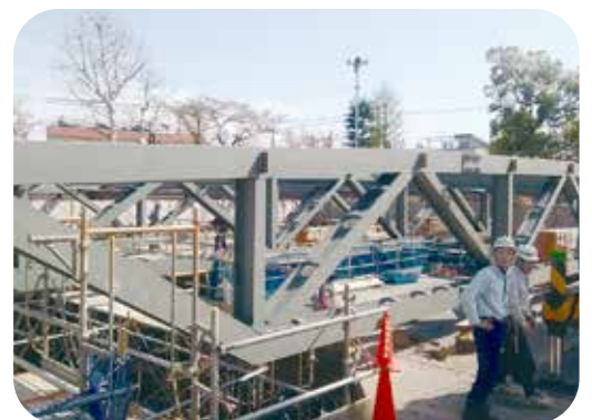
(仮称)杉並区大宮前体育館移転改築建築工事
