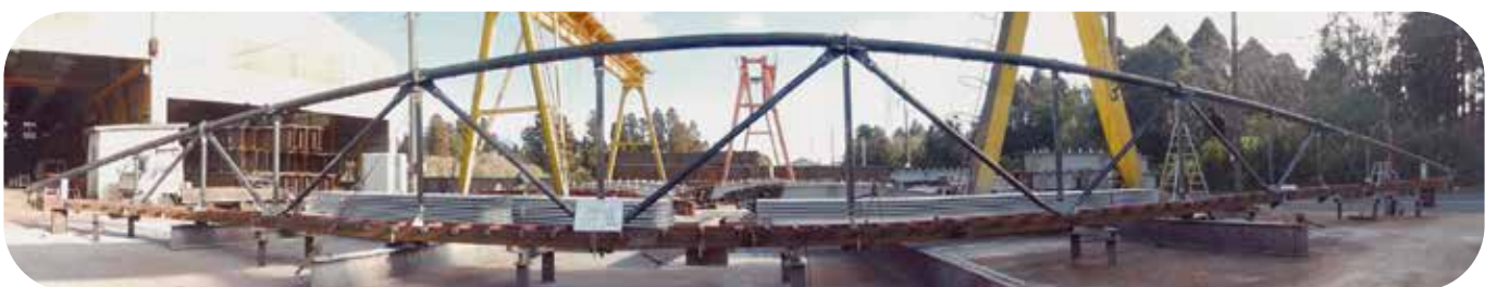
中郷中学校屋内運動場改築工事
