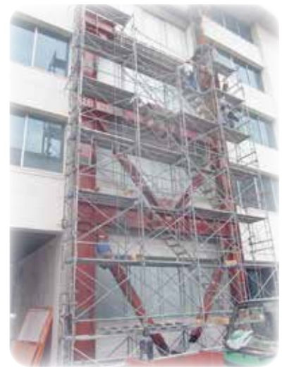
千葉県建設業センター耐震補強工事
