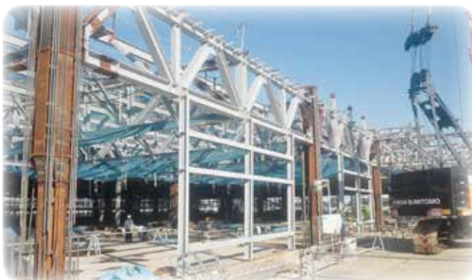
三輪精機株式会社 本社工場新築工事
