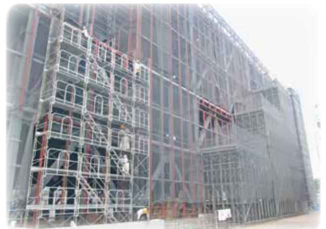
ロッテ狭山工場第4工場建設事業
