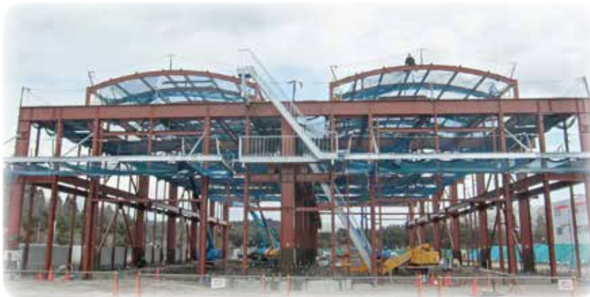
KOIKEテクノ土気工場棟及び事務所棟新築工事
